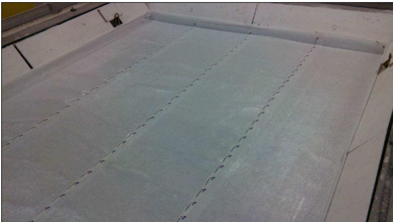
Mise en place de la sous-couche
