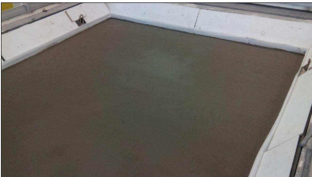
Mise en œuvre de la chape
