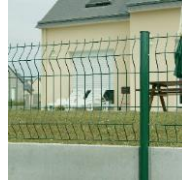
Pose avec plaque de soubassement
