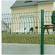
Pose avec plaque de soubassement
