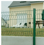
Pose avec plaque de soubassement
