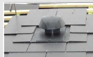
**1 - Recouper** le liteau et l'écran de sous-toiture en vue du positionnement du chapeau de ventilation.
