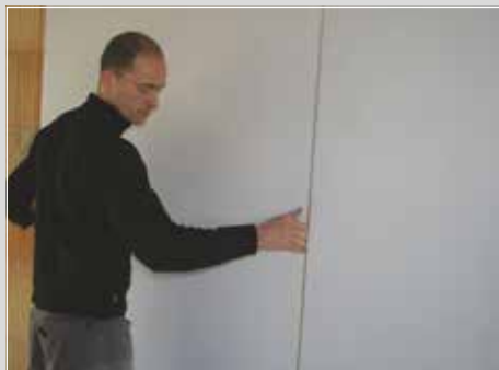
1- Poser l'isolant Efimur® .
