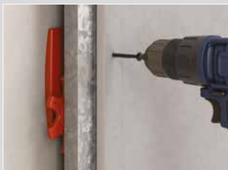
8- Poser les plaques de plâtre.
