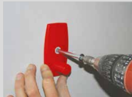
3- Fixer Efi Clic sur le panneau Efimur® .
