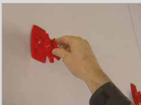
4- Assembler l'appui Efi Clic .
