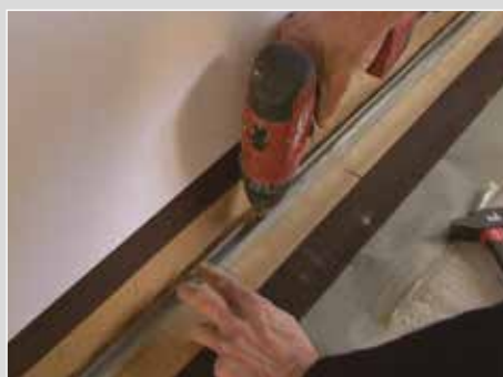
5- Fixer mécaniquement les lisses hautes et basses*.
