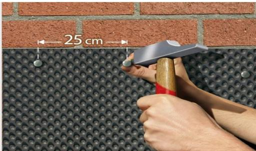
FONDALINE® doit être fixé avec les alvéoles vers l'intérieur afin d'assurer un flux d'air sur la maçonnerie. Fixez-le avec des clous et des rondelles FONDALINE® appropriés tous les 25 cm.
