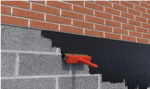
Nettoyer le support, réparer les trous. Appliquer une couche d'ONDUPRIMER®.
