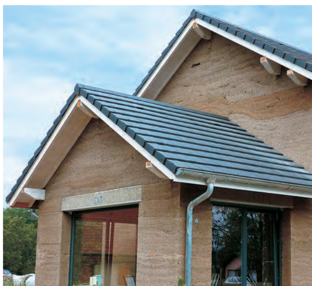
MAISON EN BÉTON DE CHANVRE Arbusigny (Haute-Savoie)
