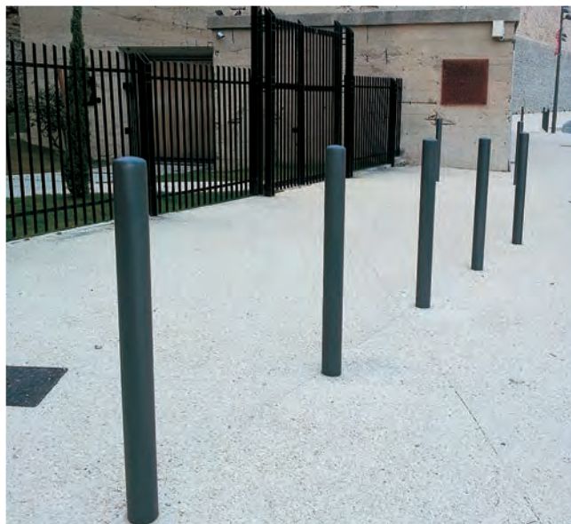
SCELLEMENTS DE POTEAUX
