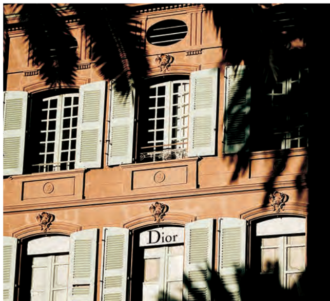
RESTAURATION DE FAÇADE DE LA VILLA DE L'AMBASSADE, MAGASIN DIOR Saint-Tropez (83) – Agence d'architecture LAC – Entreprise Les Ateliers du Paysage
