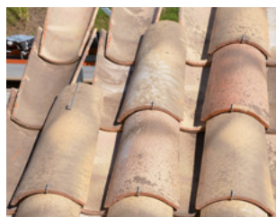
Pose sur liteaux Fixation des tuiles de couvert entre elles
