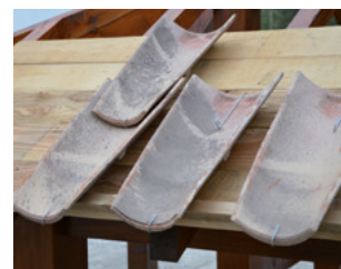
Pose sur support continu Fixation des tuiles de courant entre elles
