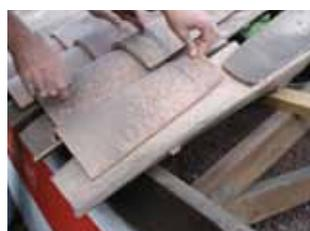
5 Avec un pureau longitudinal de 42 cm au 2<sup>e</sup> rang, la tuile coupée de départ est en pose décalée à l'égout.
