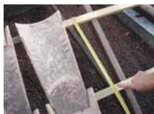
1 Les courants se posent longitudinalement entre 36 et 42 cm (pureau variable: 36 cm < pureau longitudinal < 42 cm)<sup>(1)</sup>.
