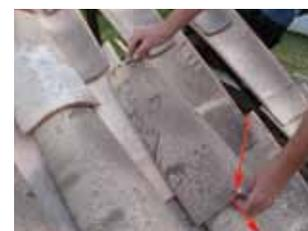
4 Le couvert est alors placé parallèlement au plan de la toiture. Le couvert est "tiré" vers le bas de la toiture. Ainsi, les ergots du couvert viennent "naturellement" en butée contre les crans des courants. Le couvert est alors solidarisé intimement sur les courants inférieurs: l'anti-glisser est assuré.
