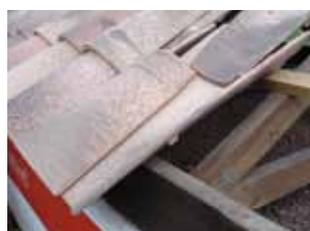
6 Avec un pureau longitudinal de 36 cm au 2<sup>e</sup> rang, la tuile coupée de départ est en pose alignée à l'égout.
