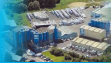
SEMIN Usine de production Kédange sur Canner / France
