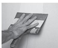
Appliquer une couche de colle enduit joint plaque de plâtre sur le raccord des deux plaques (bords amincis ou droit).
