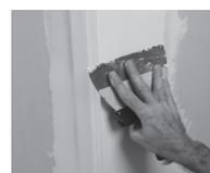
Recouvrir la bande à joint de colle enduit joint plaque de plâtre en deux passes, charge et finition.
