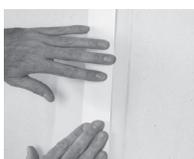
Appliquer la bande à joint sur la colle enduit précédemment appliquée sur la longueur des raccords et serrer avec le couteau à enduire. Bien plaquer la bande sur l'enduit.
