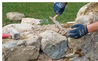
MONTAGE DE MURS
