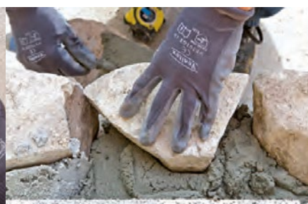
BADIGEON ENDUIT MAÇONNERIE DE PIERRE
