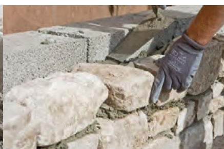
MAÇONNERIE DE PIERRES
