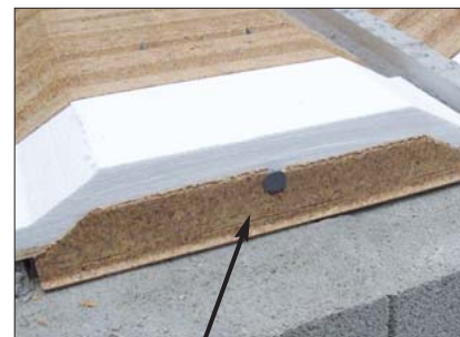
Tympan sécable incorporé dans le bouchon pour pose des rupteurs Stoptherm ES
