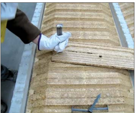
Séparation du tympan pour rupteur ES
