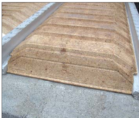
Pose de l'EBS en bout de travée avec bouchon incorporé. Toujours commencer par les extrémités avec les bouchons sur les arases
