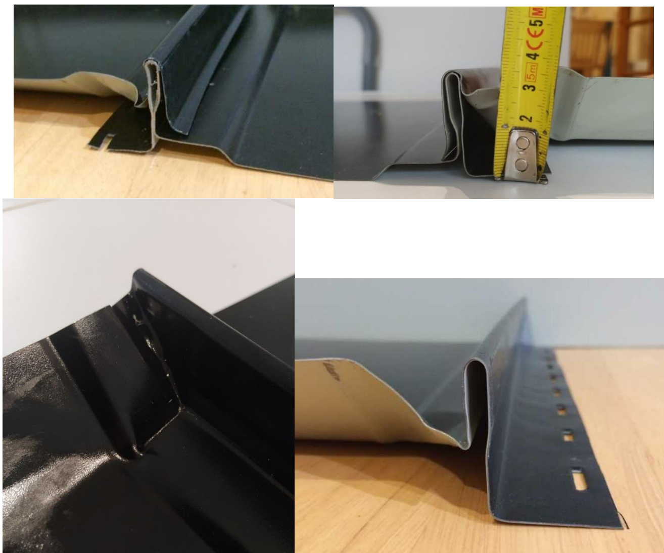
Figure 19ter - Bord relevé en faitage
