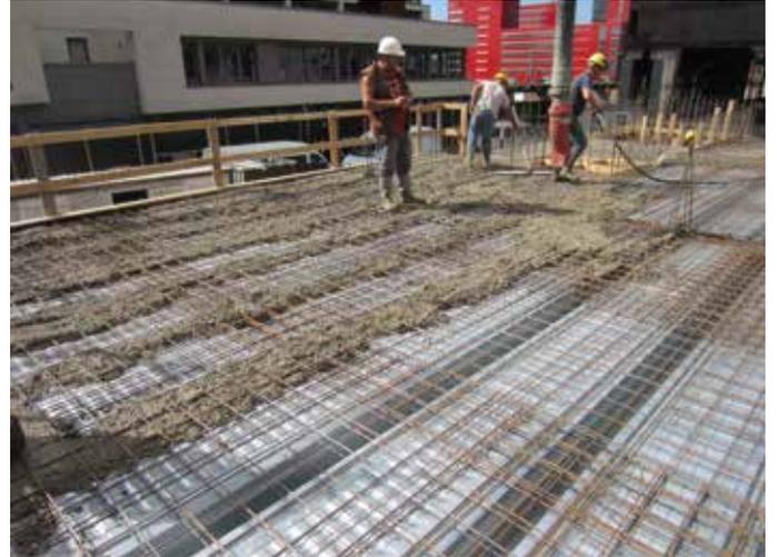
Coulage béton sur Cofraplus® 220
