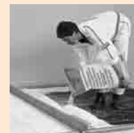
Epandre les granules d'égalisation
