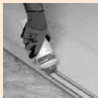
Les battues sont collées avec la colle FERMACELL
