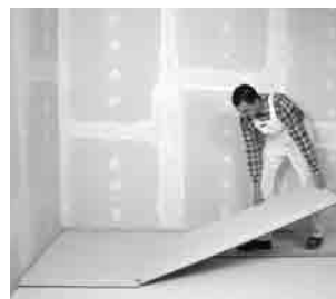
Pose des plaques de sol FERMACELL sur du granule d'égalisation FERMACELL
