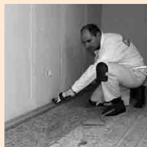
Créer la première digue
