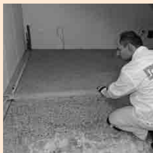
Comblé l'espace entre les deux digues avec du mortier d'égalisation
