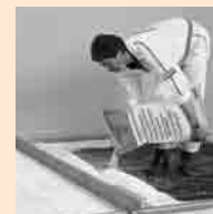
Epandre les granules d'égalisation
