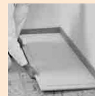
Posez les plaques de sol FERMACELL
