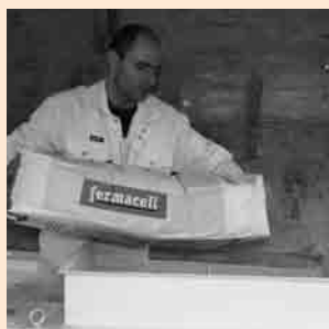
Mélanger un sac complet dans une bétonnière avec 12 litres d'eau
