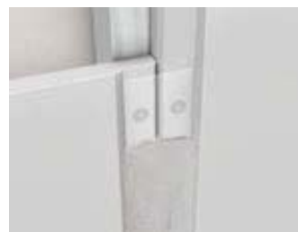
Jointoiment des plaques à bords amincis
