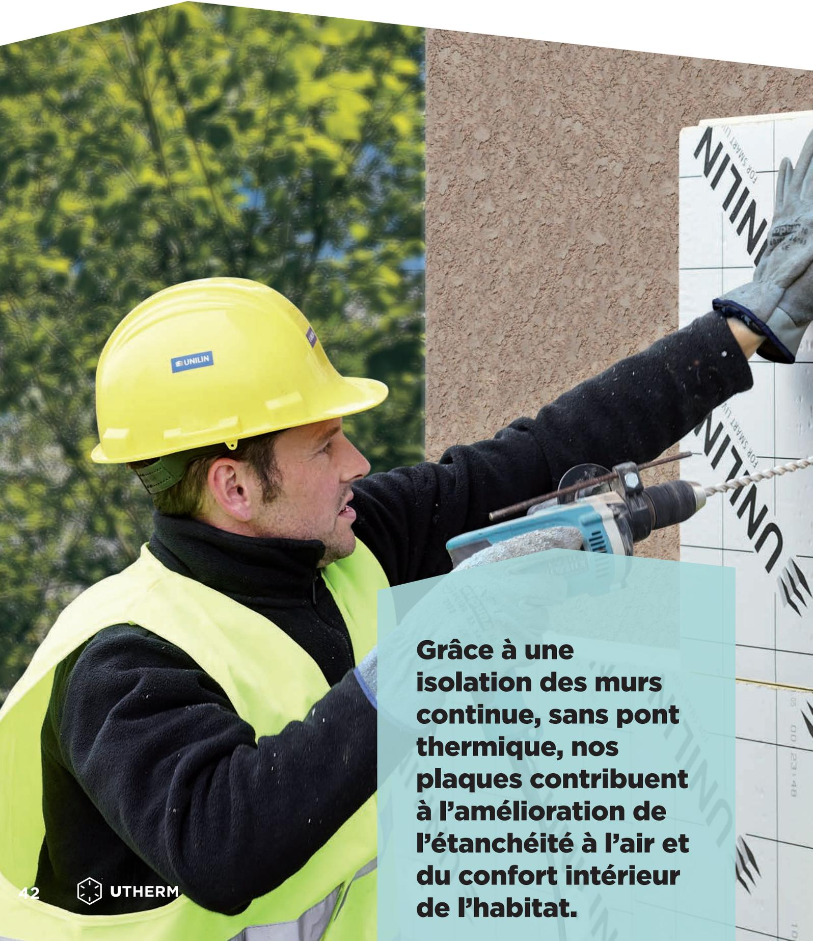
**Grâce à une isolation des murs continue, sans pont thermique, nos plaques contribuent à l'amélioration de l'étanchéité à l'air et du confort intérieur de l'habitat.**
