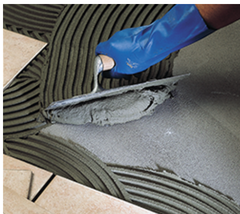
Pose de grès cérame en sol
