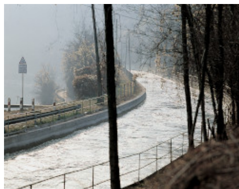
Canal hydroélectrique Bertini - Como - Italy. Surfaces traitées par Planiseal 88
