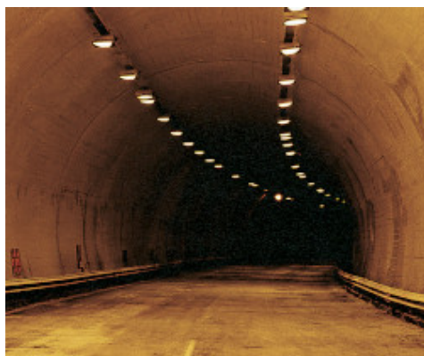
Application de Planiseal 88 par projection dans un tunnel d'autoroute
