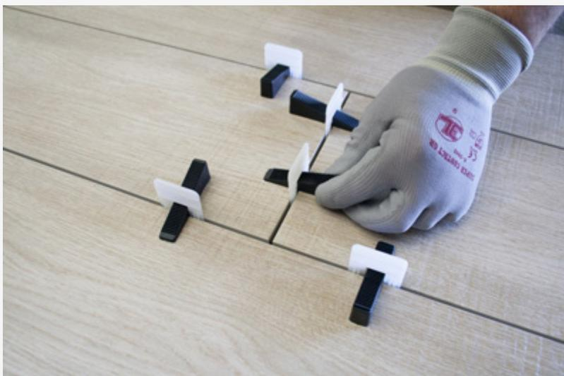
Il est déconseillé de décaler les joints de carrelage de plus de 25% pour éviter l'apparition de plis. Les réclamations pour les poses de joints décalés de plus de 25% ne seront pas acceptées.
