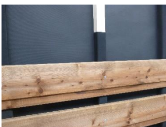
Protection des chevrons & contre-latte
