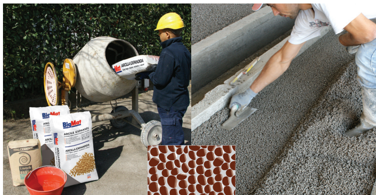
3 - Gâchée avec ciment
